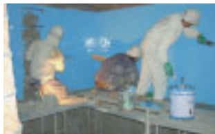
アクリエ(水道施設での塗装)
