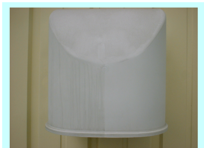
写真2 現場施工した排気口(3ヶ月経過時)
