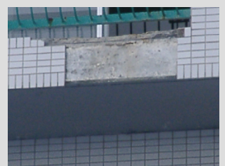
写真1 タイル外壁の劣化事例
