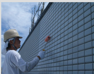
写真5 クリアウオールの塗布
