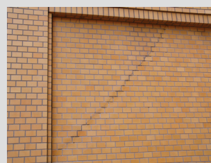
写真1 タイル外壁の劣化事例
