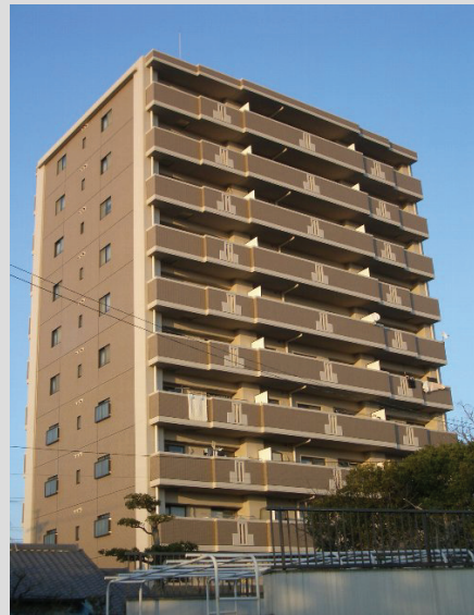
写真8 クリアウオールの施工事例
