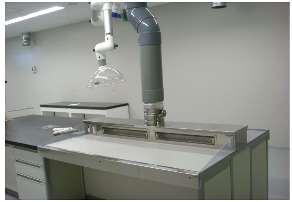
【写真5】局所排気設備の一例
